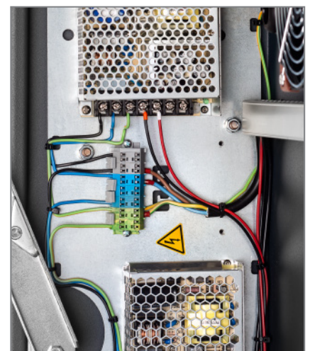
fachgerechte Verkabelung und Absicherung nach VDE (E-Check)
